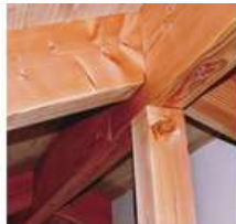
建物部分には影響が見られない
