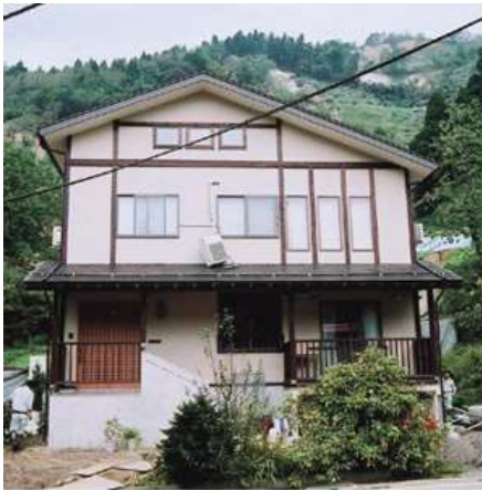
灯油タンクやエアコンの室外機が倒れているが建物には問題なし
