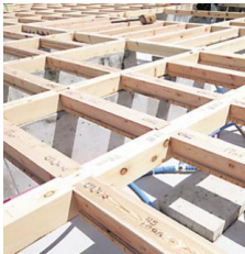
剛床工法 床剛性3.7倍 大引工法
