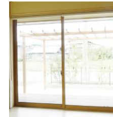
高断熱サッシ アルミ樹脂ペア・ Low-E
