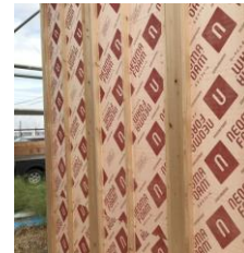
壁断熱 冷凍倉庫用断熱材を 採用
