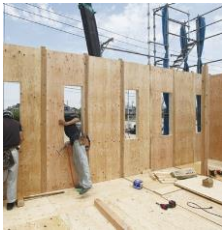
耐震壁パネル 壁倍率4.0倍
